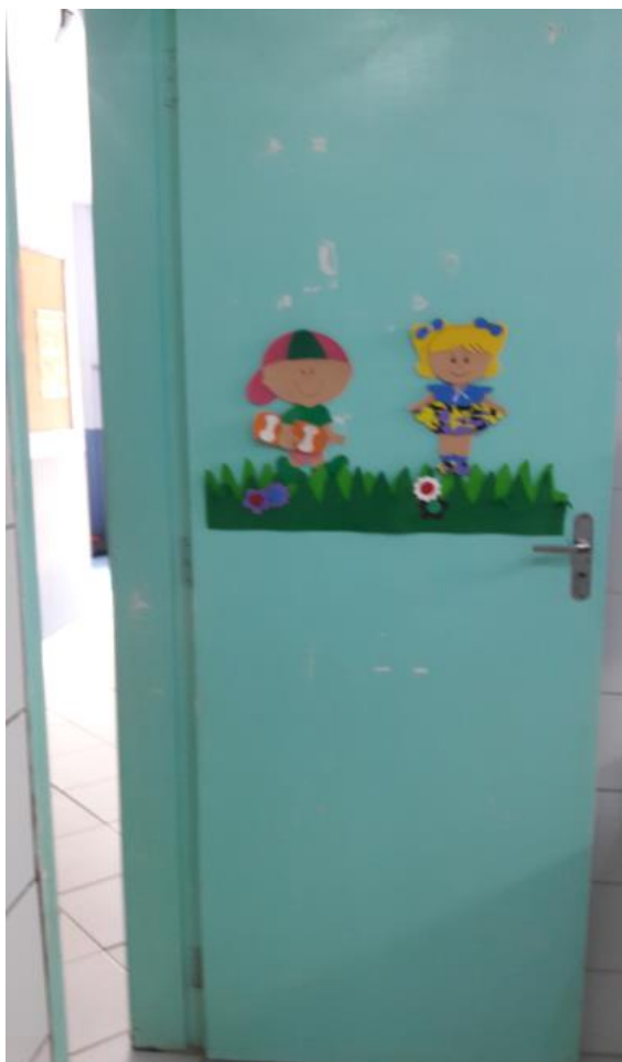
Figura 10 - Porta do Banheiro 1.
